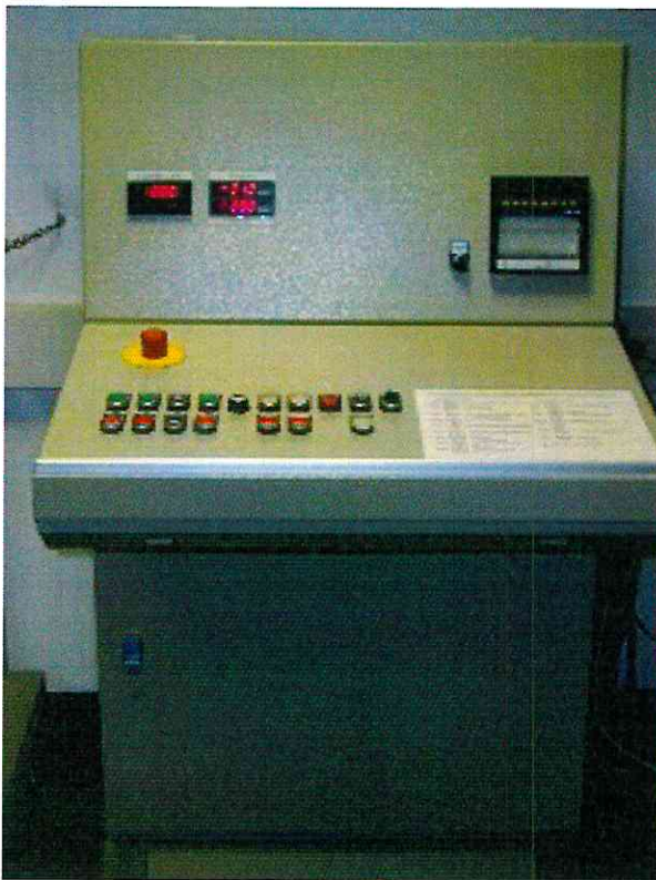
Bild 3a: Prüfstand-Steuerung (Drucksteuerung)
